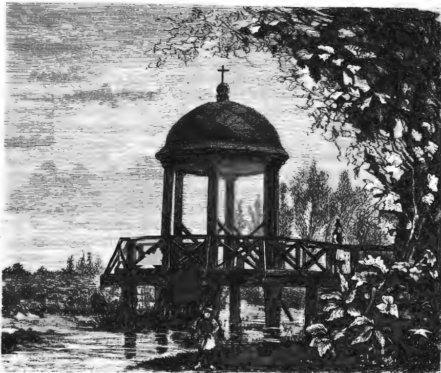
Деревянная каплица, устроенная на р. Альтѣ, близъ Переяслава.
